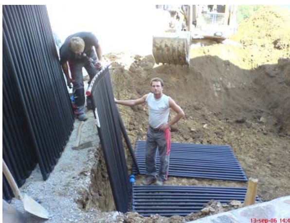
VBX kolektor horizontalna položitev
