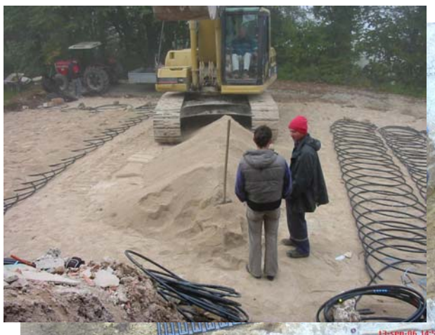
VBX kolektor horizontalna položitev
